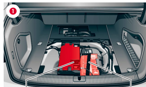
Batteria a 48 volt
