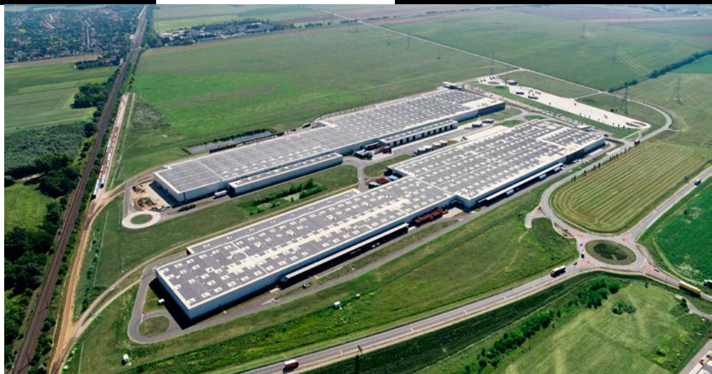
Audi Hungaria: Photovoltaikanlage auf den Dächern der beiden Logistikhallen
